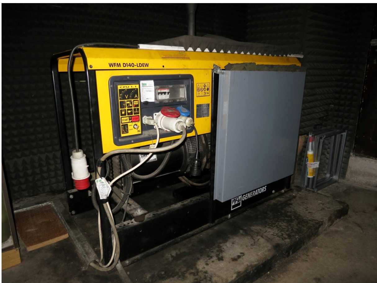
Agregat (vroč zrak, ki nastaja v hladilniku, odvajamo iz prostora po zračnem kanalu)
