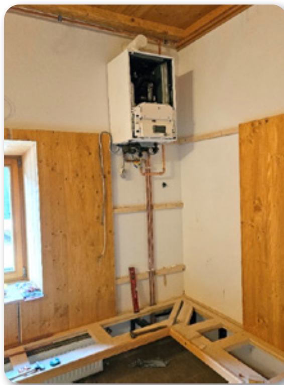
Montaža plinske centralne kurjave
