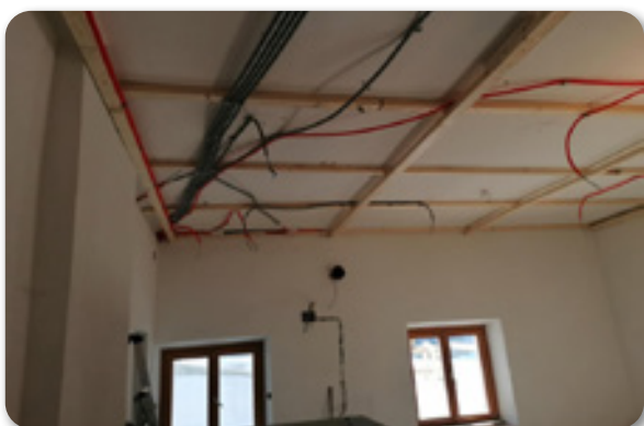
Cevi so povezane, sedaj je na vrsti lesen strop.
