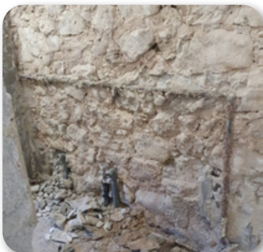
Olupljena zunanja kamnita stena
