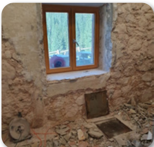
Zbirni kanalizacijski jašek
