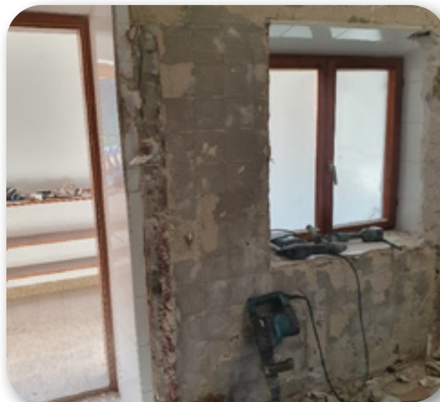
Rušitvena dela so se začela
