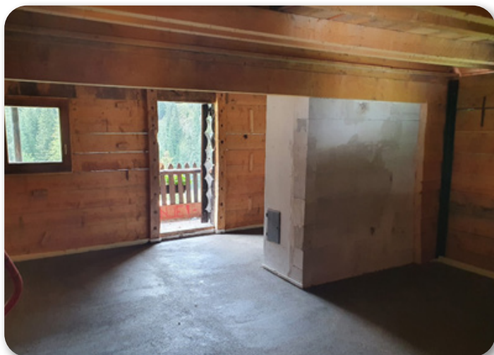
Tla so izolirana in ko se estrih posuši, gremo naprej.
