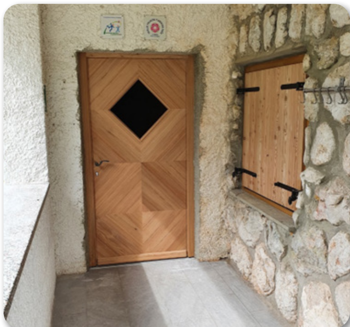
Nova vhodna vrata so vzidana.
