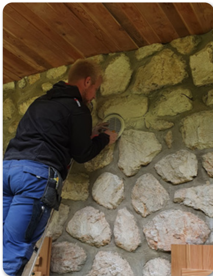
Montaža rekuperatorjev LUNOS.
