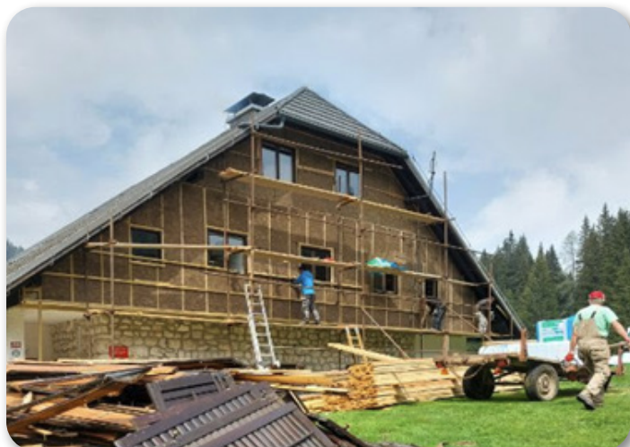
Začetek del na prednji fasadi.
