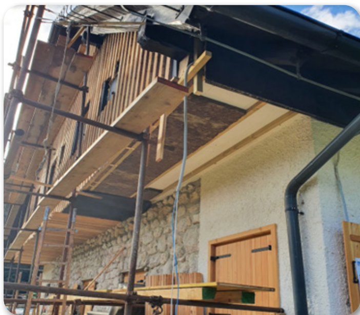
Dela na zadnji fasadi.
