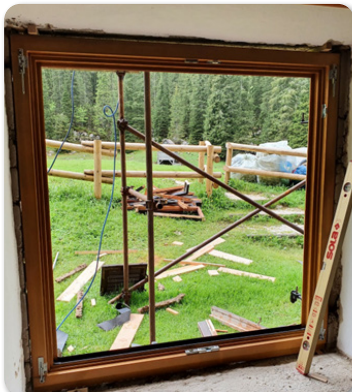
Prvi okvir za novo okno je vzidan.
