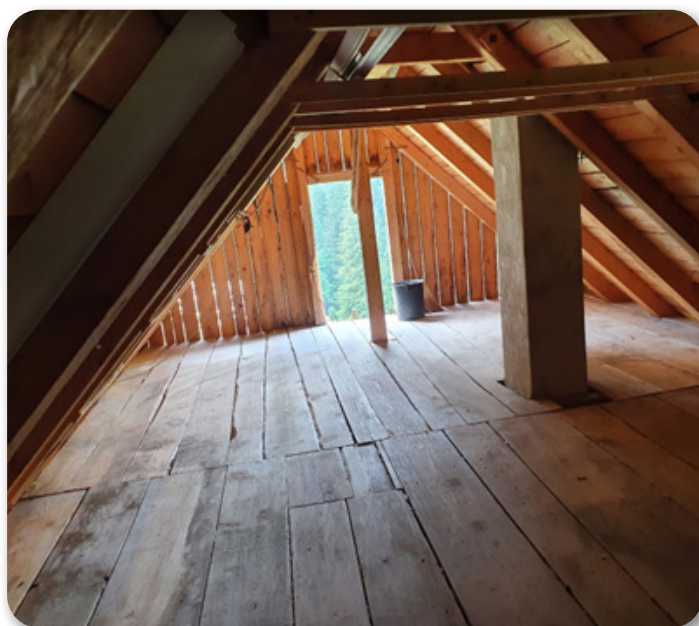
Podstreha brunarice je izpraznjena in pripravljena za mojstre.
