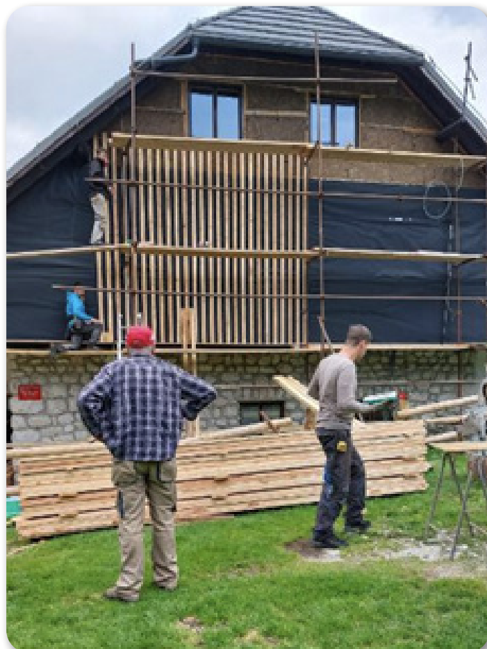
Izolacija je položena in prve deske prite.
