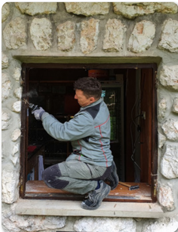
Odstranjevanje starih okvirjev.
