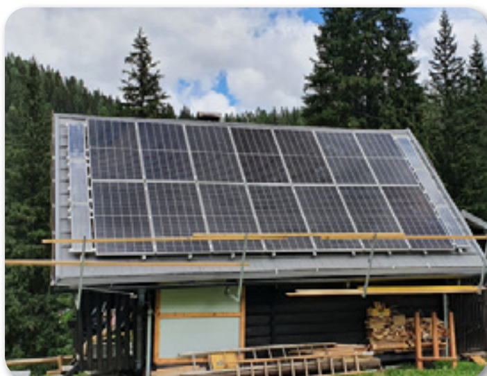
Novi solarni paneli so montirani!
