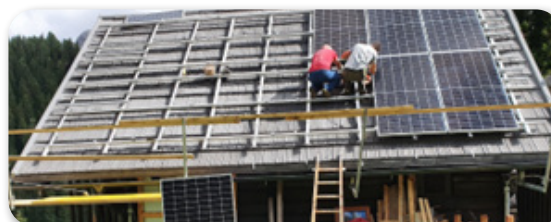
Montaža novih solarnih panelov
