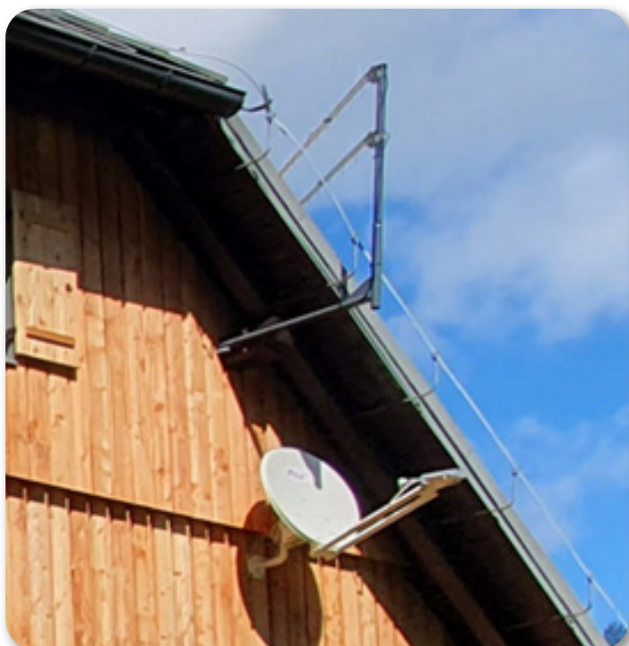
Dve strešni anteni za GSM signal, pod njima satelitski krožnik za internet
