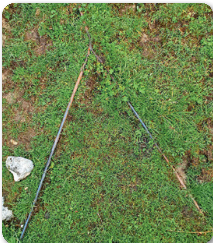
Cevi, po katerih je tekla voda iz ovna v zgornji rezervoar ob koči.
