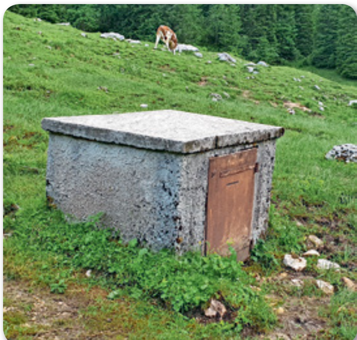
Betonska hiška s kovinskimi vrati
