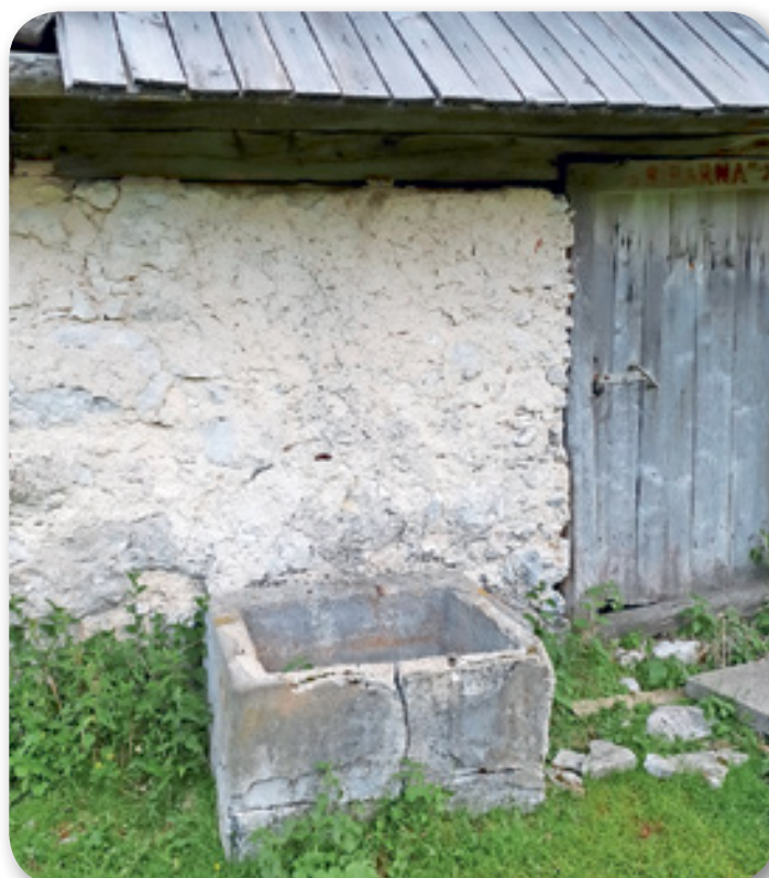
V spodnji sirarni se še danes vidi korito in nad njim cev, kjer je bila verjetno pipa.
