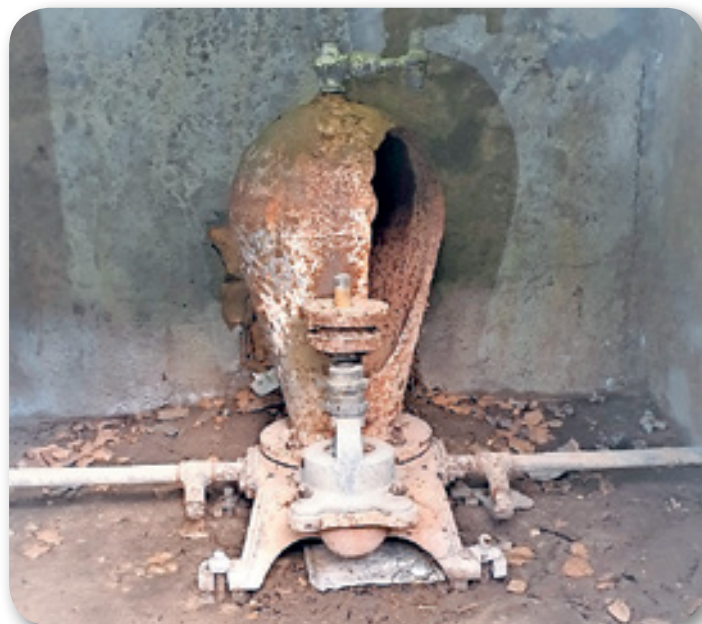
Hidravlični oven s počeno tlačno posodo
