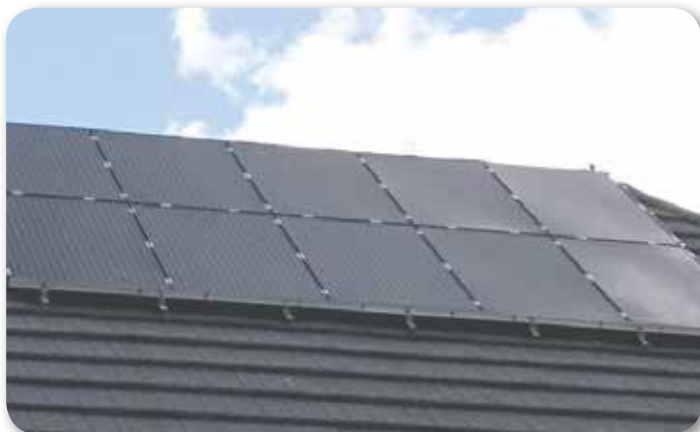
Upamo, da bo nova konstrukcija zdržala naslednjo zimo
