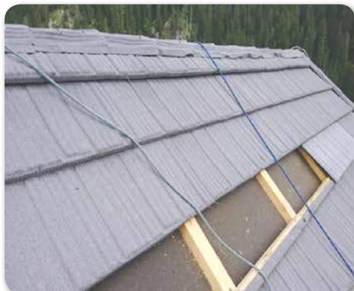
Višinska dela na strehi z alpinistično tehniko varovanja
