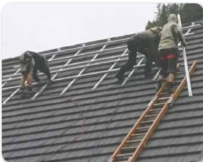
Montaža nove, močnejše, dvojne nosilne konstrukcije
