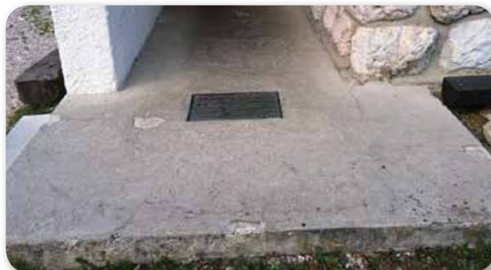
Estrih pred vhomom je dotrajan in ga bomo letos nadomestili s ploščicami.
