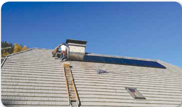
Menjava mikrorazsmernikov na panelih.
