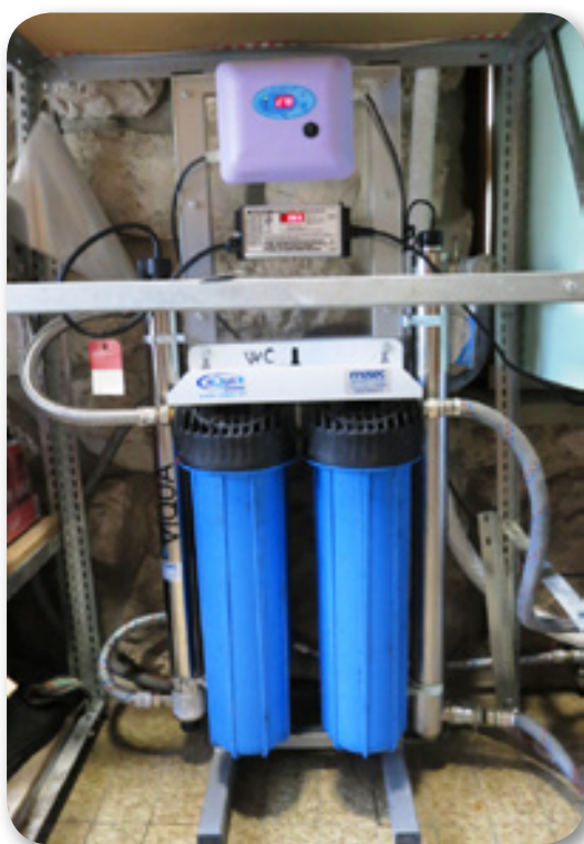
Nova sistema za filtriranje in UV dezinfekcijo
