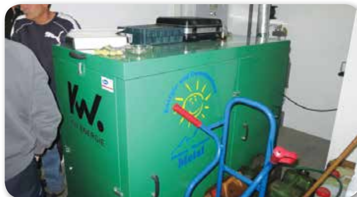
Agregat na repično olje, temperatura motorja greje vodo
